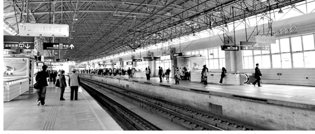
镇坪路西侧站厅将封闭施工。
