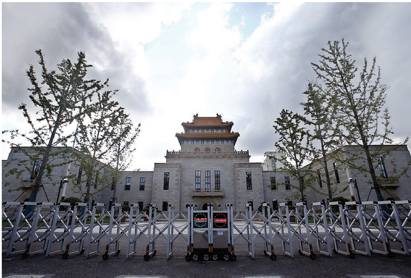
重新修缮后的杨浦区图书馆10月1日起试开放。
