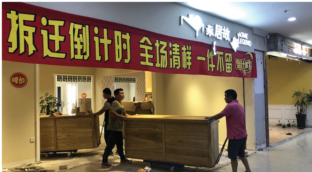
店铺员工正在现场做最后的清理搬离。
