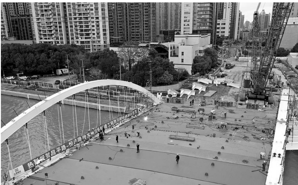
昌平路桥工程跨河钢拱桥顺利合龙。
