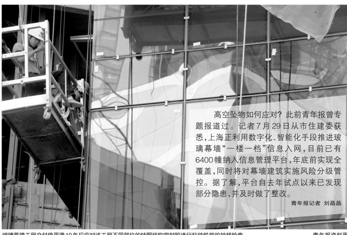
玻璃墓墙工程交付使用满10年后应对该工程不同部位的硅酮结构密封胶进行粘结性能的抽样检查。
