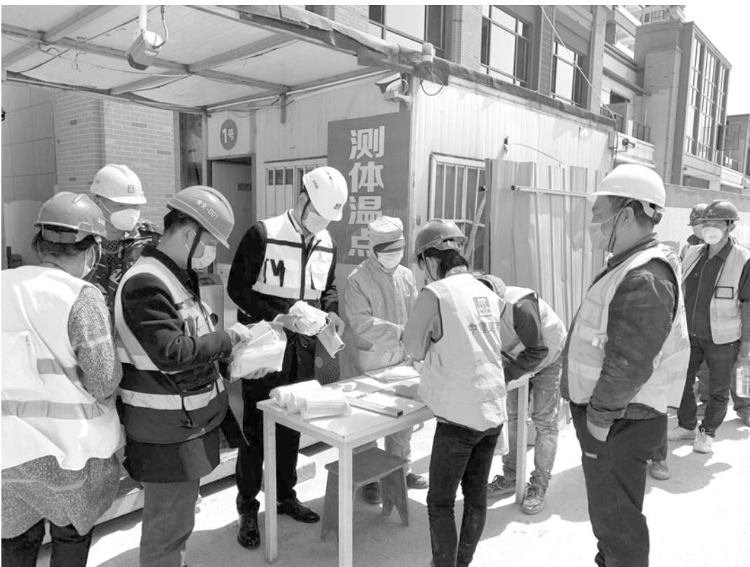
在建筑工地，王九良组织人员做好健康安全防控的同时，保证建筑项目如期推进。 本版均为受访者供图
