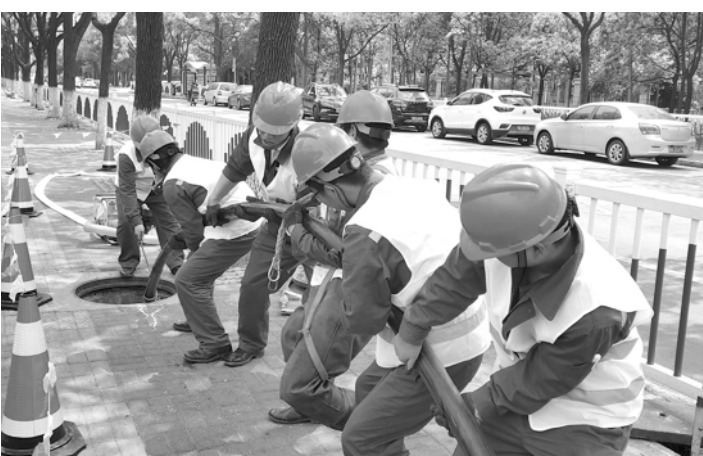
电信员工正在施工。
