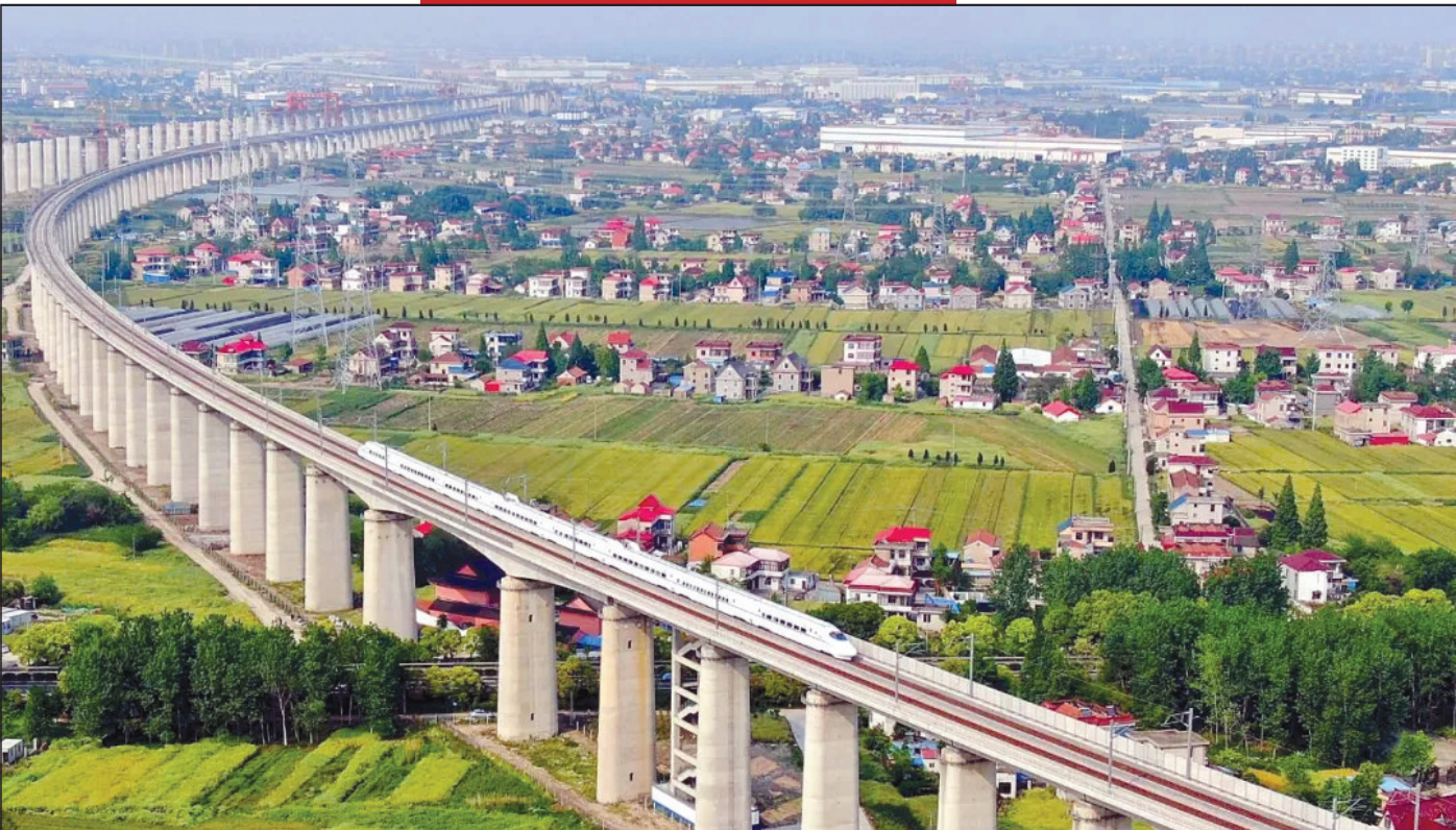
联调联试期间,动车组列车飞驰在沪苏通铁路上。
