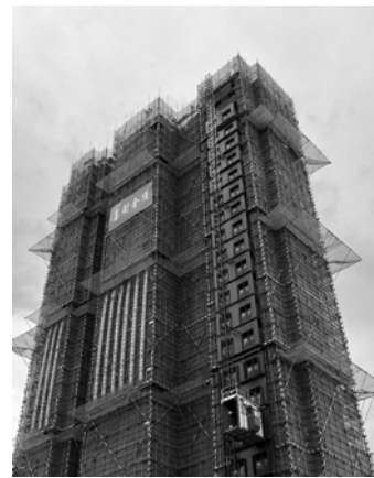
保障住房项目5号楼主体结构封顶。 受访者供图
