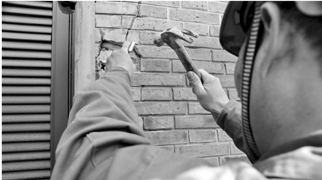
施工人员正在对中共二大会址纪念馆的外立面进行修缮。
