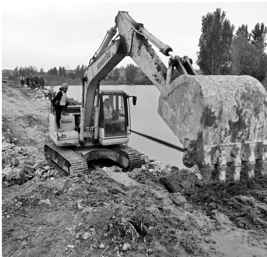
汾河山西新绛段桥东村附近堤坝决口成功合龙。
