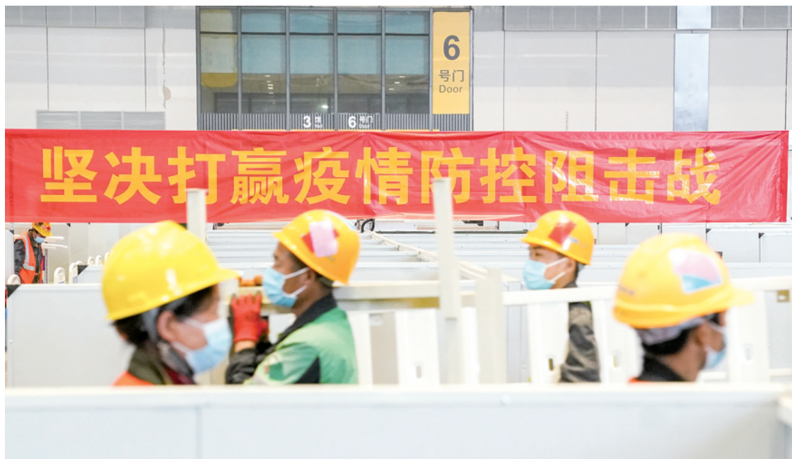
4月8日,工人在国家会展中心方舱医院作业。
