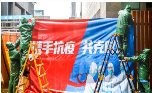
青年员工正在冒雨抢建室外医废专用垃圾房。
