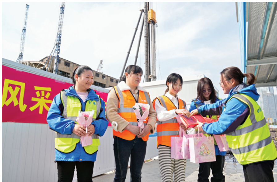
昨天,中建三局上海哔哩哔哩新世代产业园项目部工地的女工领取节日慰问品。
