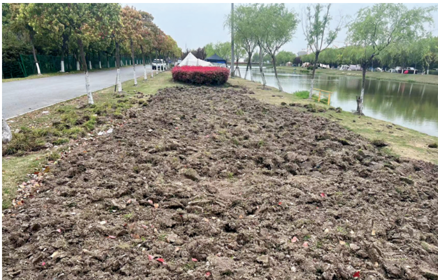
记者在现场看到,河道旁的两处草坪已翻土动工。 本版摄影 青年报记者 顾金华
