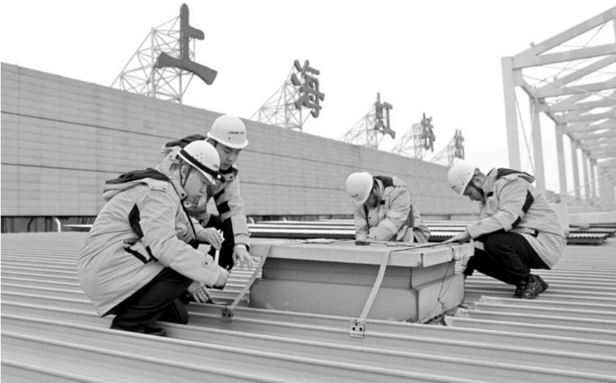
“站房医生”们进行房建设备巡检作业。
