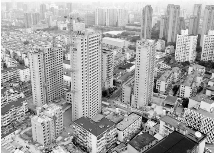
上海市静安区谈家桥城市更新项目建筑工地。 新华社 图
