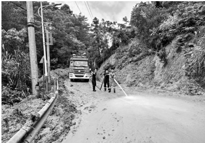
6月21日，龙岩上杭县消防救援大队队员在清理村道淤泥。
