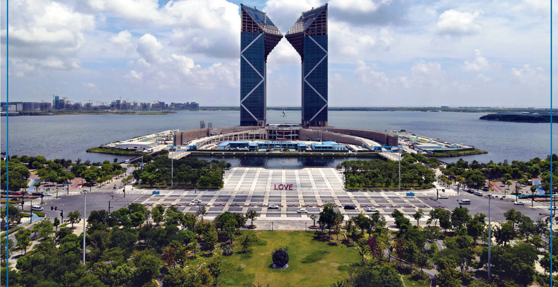
空中俯瞰临港新片区滴水湖西岛中银金融中心项目现场。
