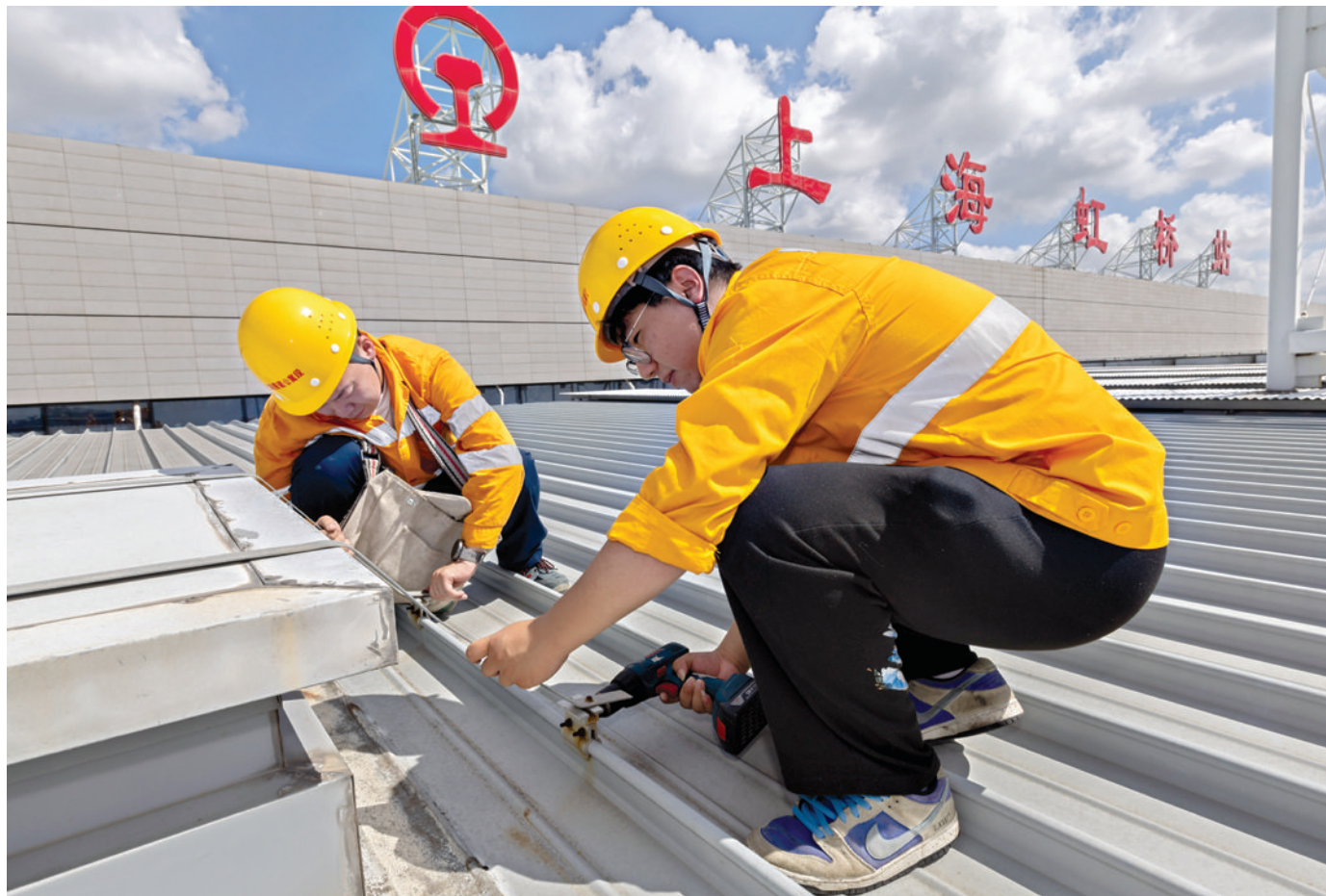
9月13日,房建巡检工在上海虹桥火车站屋顶上作业,确保小长假期间铁路运输安全。
