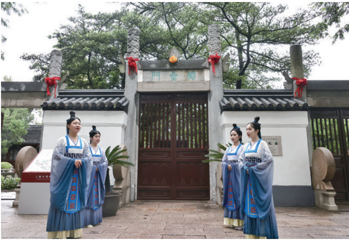
完成修缮后的嘉定孔庙。
