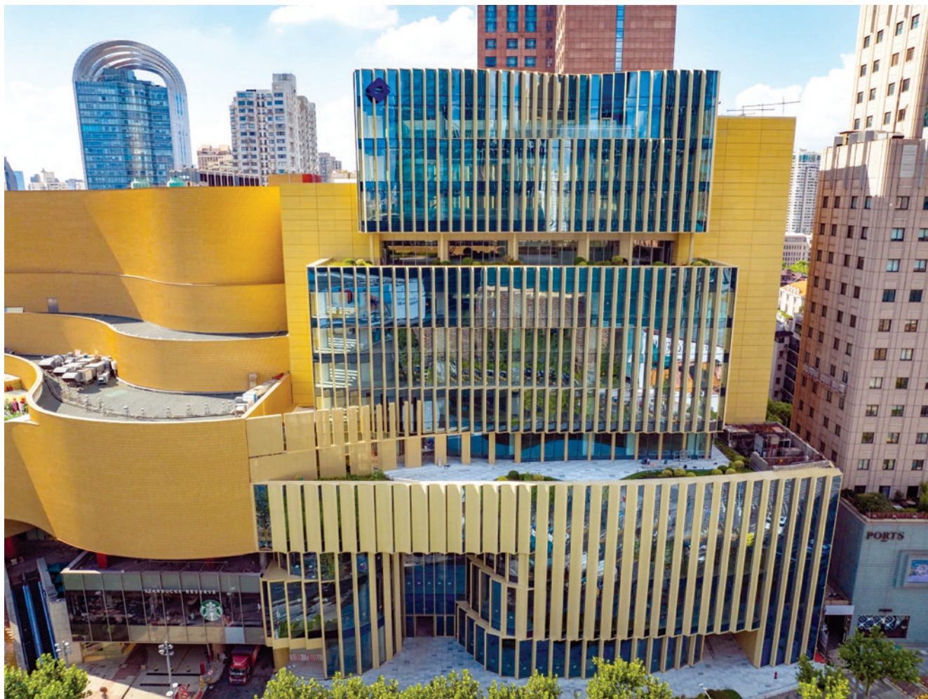
改造后的上海机场城市航站楼。
