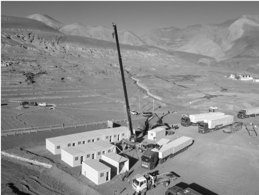
工作人员在定日县长所乡嘎旦村搭建板房。
