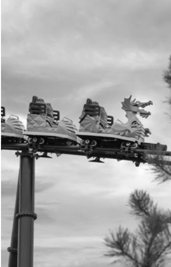
飞龙过山车安装完成。
