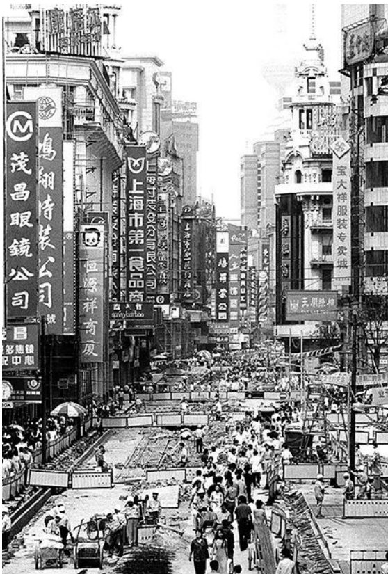
1999年7月,正在建设中的南京路步行街。
