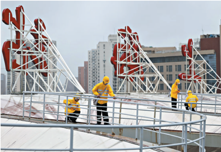
▲上海房建公寓段房建巡检工在上海火车站屋面检查防护栏杆稳定性。
