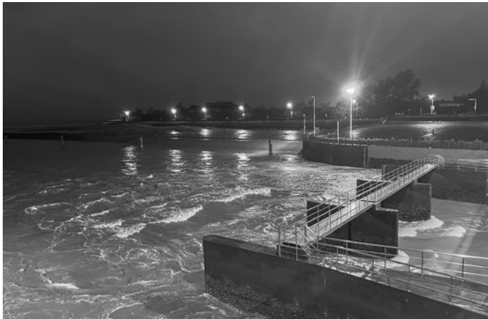
金汇港南闸三孔全开。
