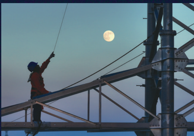
高塔架线工人在月光的映射下施工。
