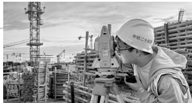
工程技术人员在测量数据。
