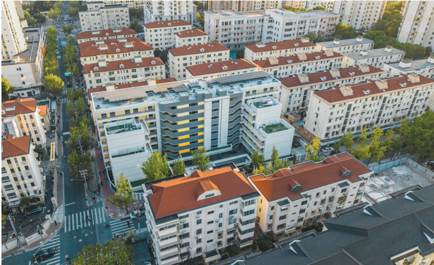
现漕溪三村重建后实景航拍。
