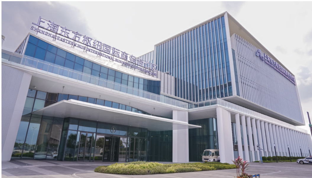
上海东方枢纽国际商务合作区先行启动区完成验收。
