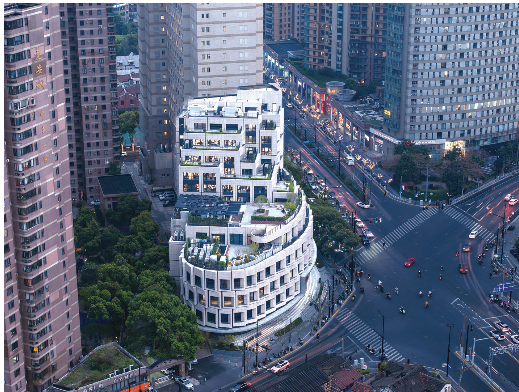
该项目是上海经过检测的第一栋超低能耗公共建筑。
