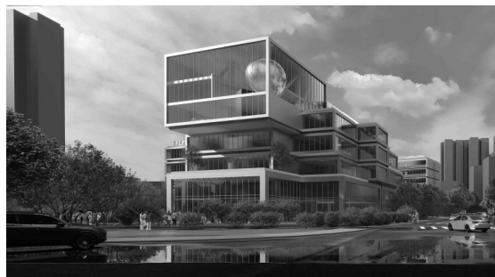
同济大学科技中学改扩建工程。
