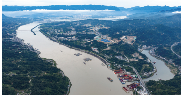
三峡水运新通道工程三峡枢纽新通道施工现场。
